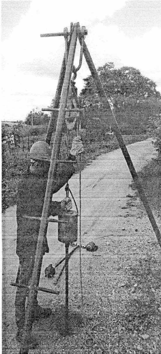
Figura 3: sondagem à percussão
